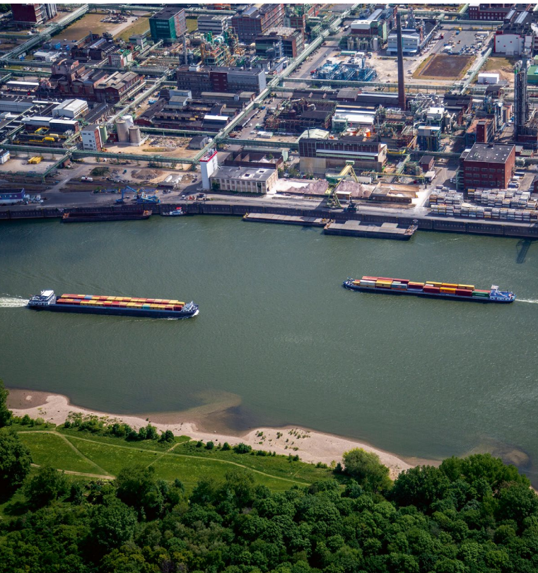
Bundesanstalt für Wasserbau
