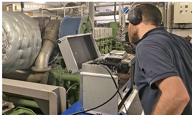
Im Maschinenraum der MTS Lynn wird eine Messdatenaufnahme durchgeführt.
