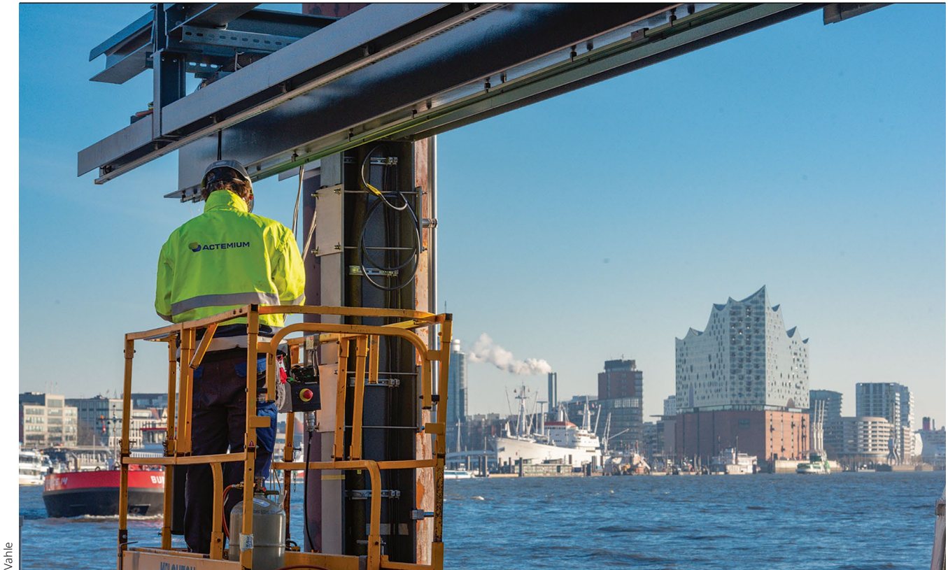
Montage auf dem Ponton: Die Baustelle auf der Elbe war besonders für das Vahle-Team.
