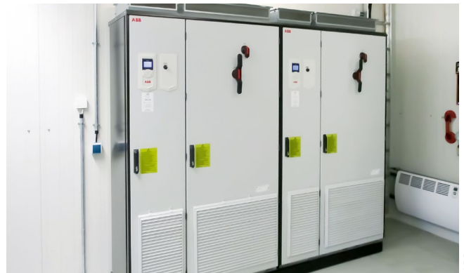
Vier Multidrive-Frequenzumrichtersysteme ACS880 von ABB sorgen für den Gleichlauf der Motoren.
