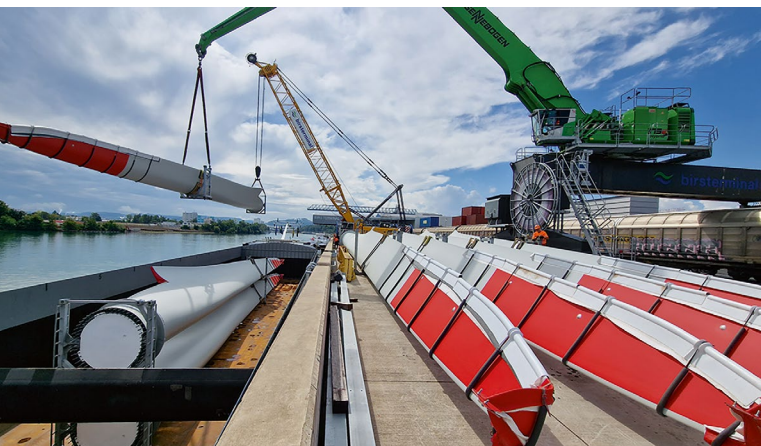
Die XXL-Komponenten für eine Windkraftanlage erfordern eine schwerlastfähige und geräumige Infrastruktur.
