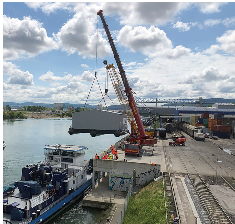
Für die Rheinrettung Basel wurde ein neues Bootshaus auf dem Terminal gebaut und im Tandemhub eingewassert.
