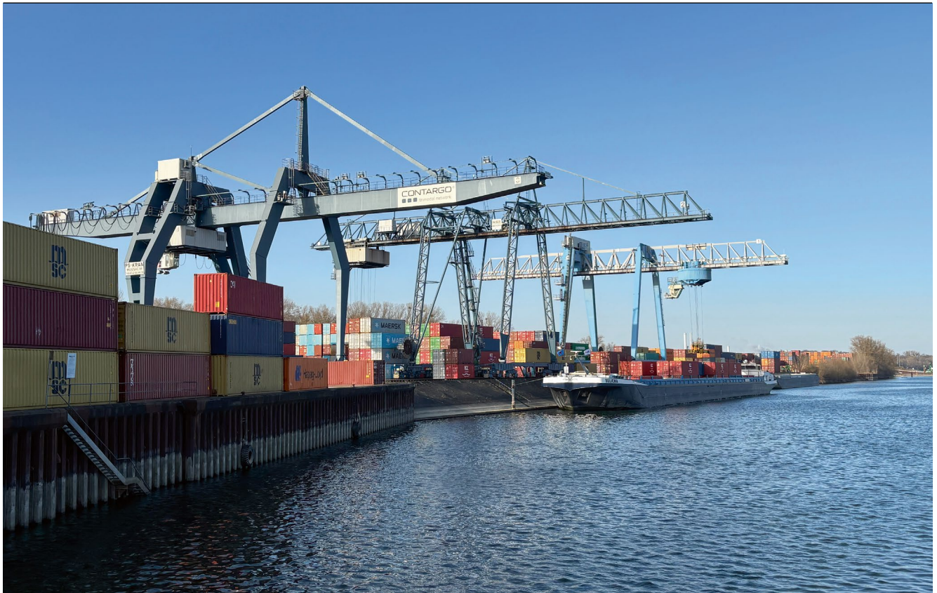
Schiffsanleger im Contargo-Terminal Wörth: 380 Meter Kailänge, zwei Kräne und 40.000 Quadratmeter Umschlagfläche.
