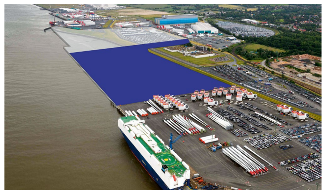
Dank der drei neuen Liegeplätze entsteht eine durchgängige Kaianlage in Cuxhaven.
