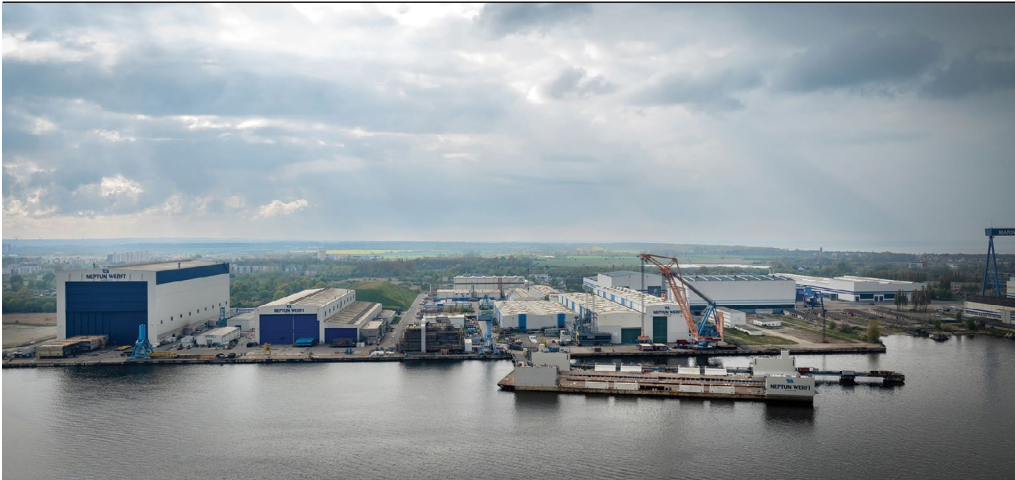
Die Neptun Werft aus der Luft: Sie ist auf den Bau von Flusskreuzfahrtschiffen sowie schwimmenden Maschinenraummodulen spezialisiert.
