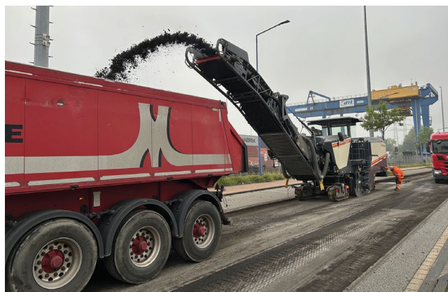
Derzeit lässt Duisport die Straßen auf Logport 1 sanieren.
