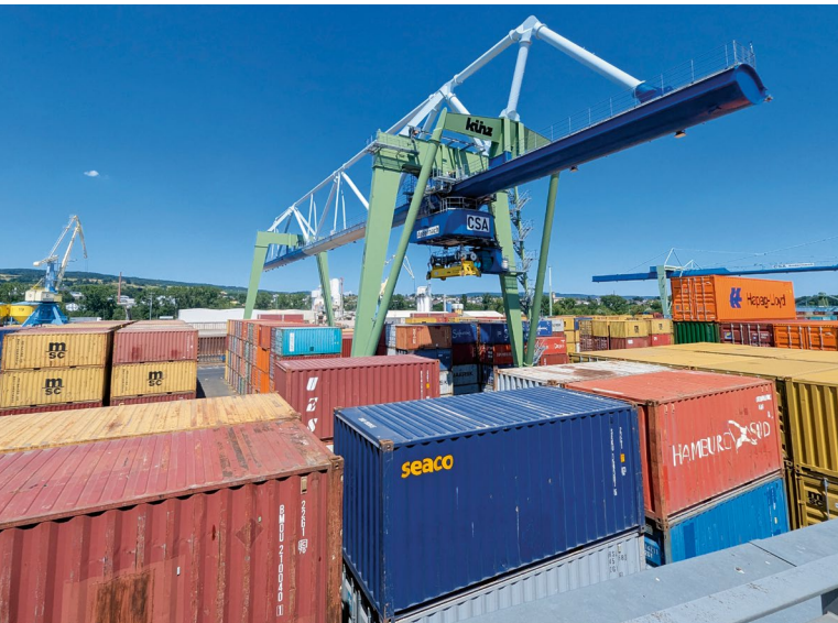
Die Umschläge im Hafen Andernach steigen, sodass dieser seit 2024 wieder eigenwirtschaftlich arbeitet.
