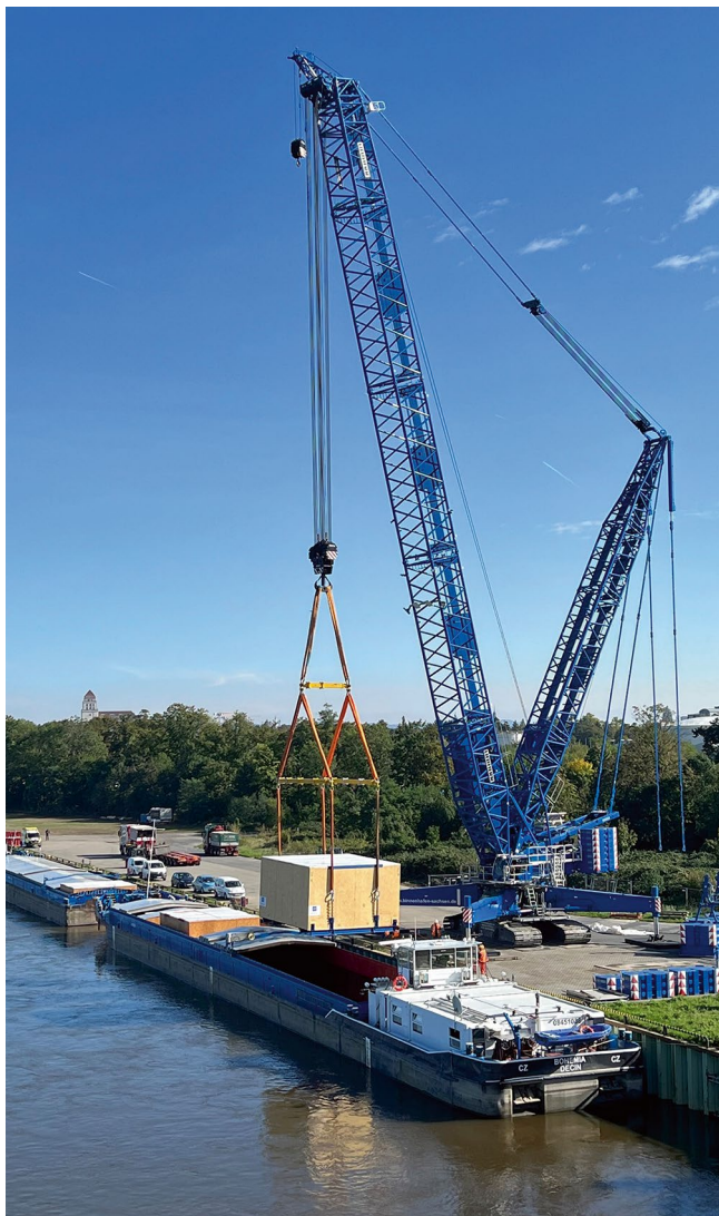
Große Massen per Kran aufs Binnenschiff: SBO zeigt, dass Projekte wie diese auf den Wasserstraßen funktionieren.
