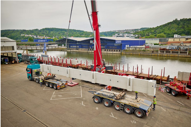
Ein etwa 25 Meter langes Betonfertigteil wird mit dem Kran vom Zug auf den Lkw gehoben.
