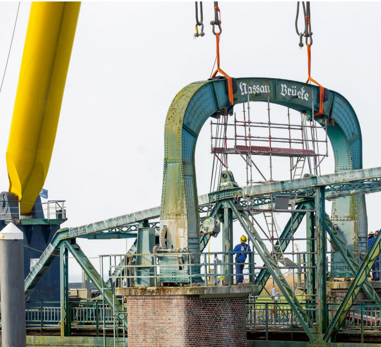
Ein Kran hebt den Portalbogen der Nassaubrücke an.
