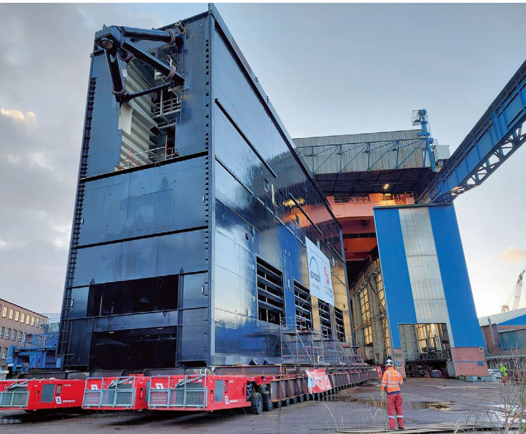
Vier gekoppelte Schwerlastmodule waren erforderlich, um ein Schiebetor zu bewegen.
