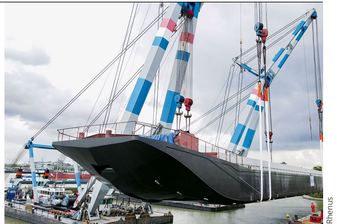
Aufnahme des Zuwasserlassens des Leichters für die „Mannheim I+II“ in der Werft in Rotterdam.
