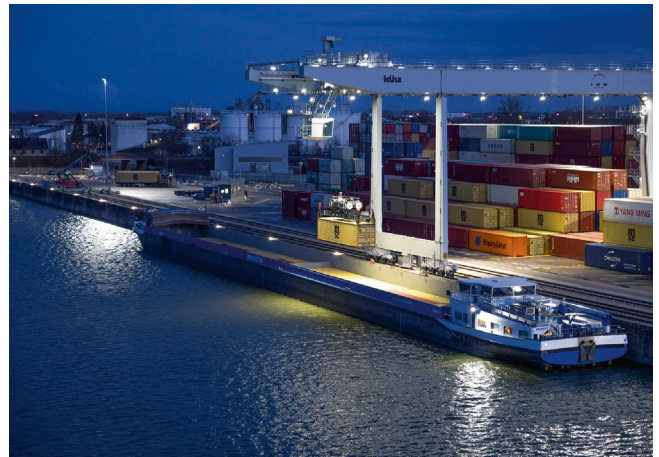
Verladung von Containern auf das Binnenschiff im trimodalen Containerterminal im bayernhafen Regensburg.
