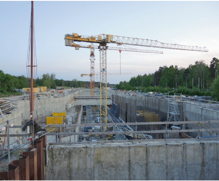
Der Neubau einer zweiten Schleusenammer bei Zerben am Elbe-Havel-Kanal dient der Ertüchtigung der Wasserstraße Magdeburg-Berlin für 2,80 m Abladetiefe. Auf dem Kanal werden pro Jahr rund 2 Mio. Tonnen Güter transportiert.
