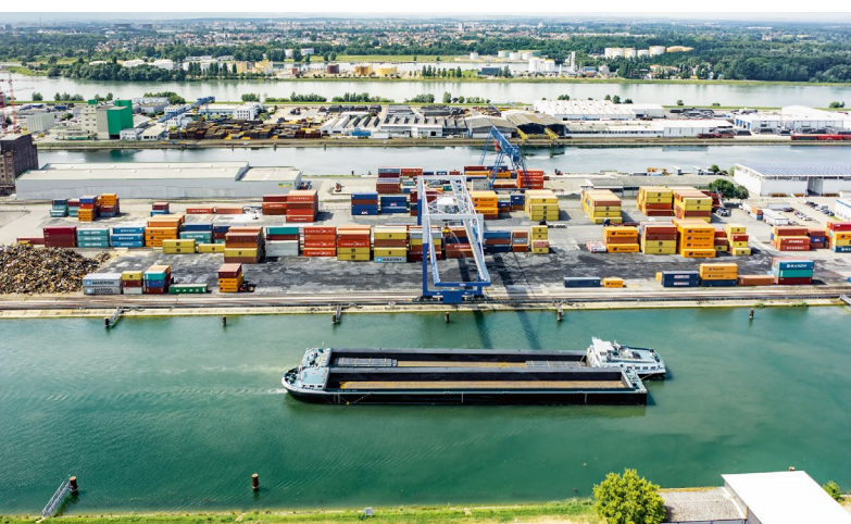
Auch im Hafen Kehl rechnen die ansässigen Unternehmen mit steigenden Gütermengen in den nächsten Jahren.
