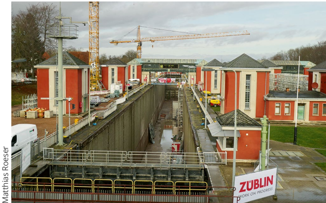
Ein Blick auf die Hindenburgschleuse bei Hannover-Anderten.
