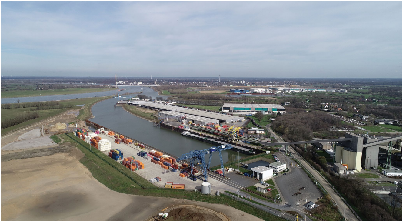
Das Container-Terminal im Hafen Emmelsum befindet sich in der Erweiterung. Es ist ein wichtiges Element in den Logistik-Konzepten des DeltaPort. Essentiell ist die Zuwegung für den Bahnverkehr.
