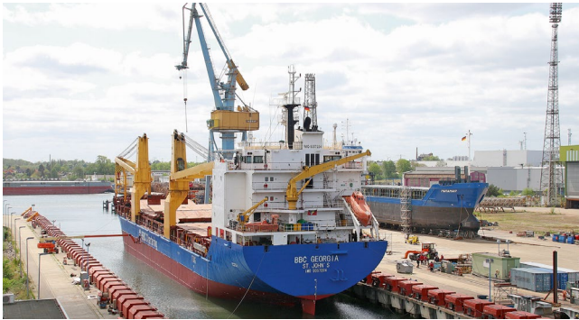
Der Schiffsliift dockt Schiffe bis zu einer Länge von 260 Metern. Im Bild die 136 Meter lange „BBC Georgia“.
