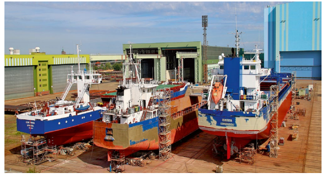
Der Schiffsliift und ein weites Verschiebegelände ermöglichen es, gleichzeitig mehrere Schiffe zu docken.
