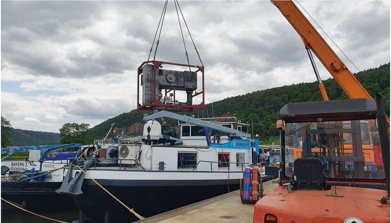
Einbringen des Russfilters in das GMS „Rhönland“.
