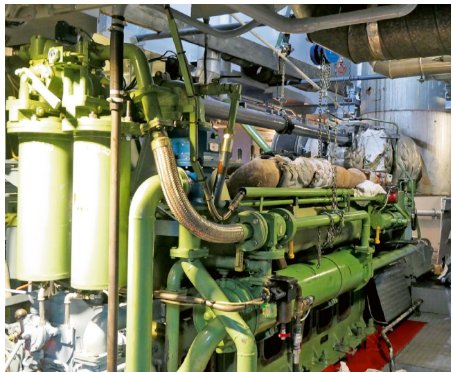
Der ABC Motor des GMS Henneburg bekommt eine Revision.
