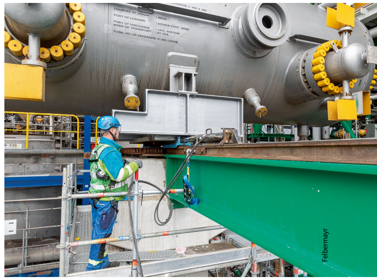
Der erste Hydrolizer wurde mit einem eigens dafür konstruierten Verschiebesystem in Stellung gebracht.
