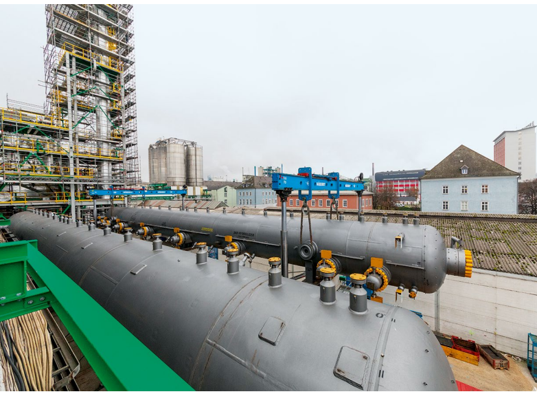
Die präzise Fundamentstellung erfolgte per Hubgerüst.
