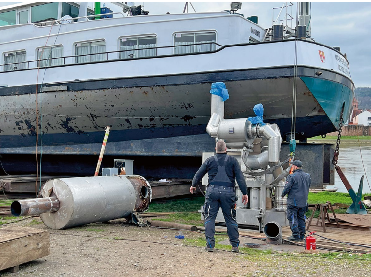
Ein Einblick in die Montage auf der Werft. Links der alte Schalldämpfer, rechts die neue kombinierte Abgasreinigungsanlage von Tehag.
