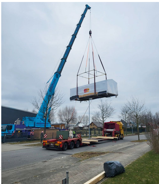
Neben langwierigen Genehmigungsverfahren erschwert auch das unzureichend „gefütterte“ Genehmigustool die Transportdisposition.
