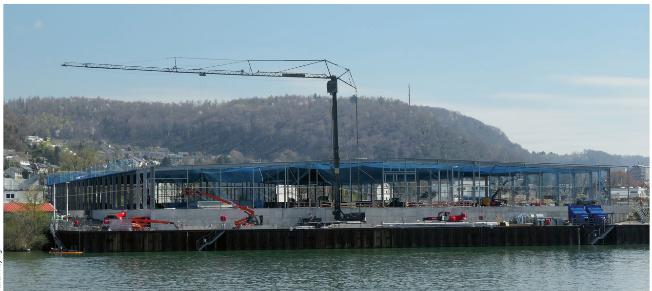
Die Aushubhalle im deutschen Grenzach ist inzwischen vollständig demontiert.
