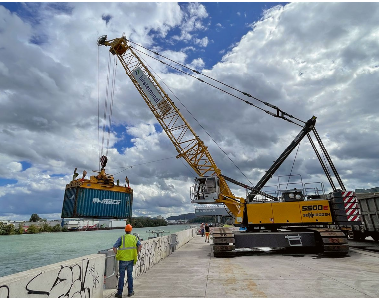
Der neue Sennebogen-Raupenkran kann bei Schwergutumschlag ebenso unterstützen wie bei der Containerverladung.
