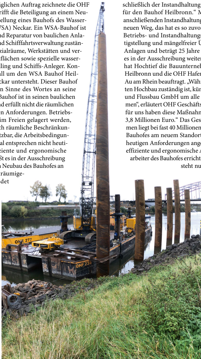
Wasserbau-Kompetenz: Kaimauern, Schiffsverlade- und Umschlagsanlagen, Uferböschungsbauwerke in Spundwandbauweise in senkrechter wie in kombinierter Bauweise.
