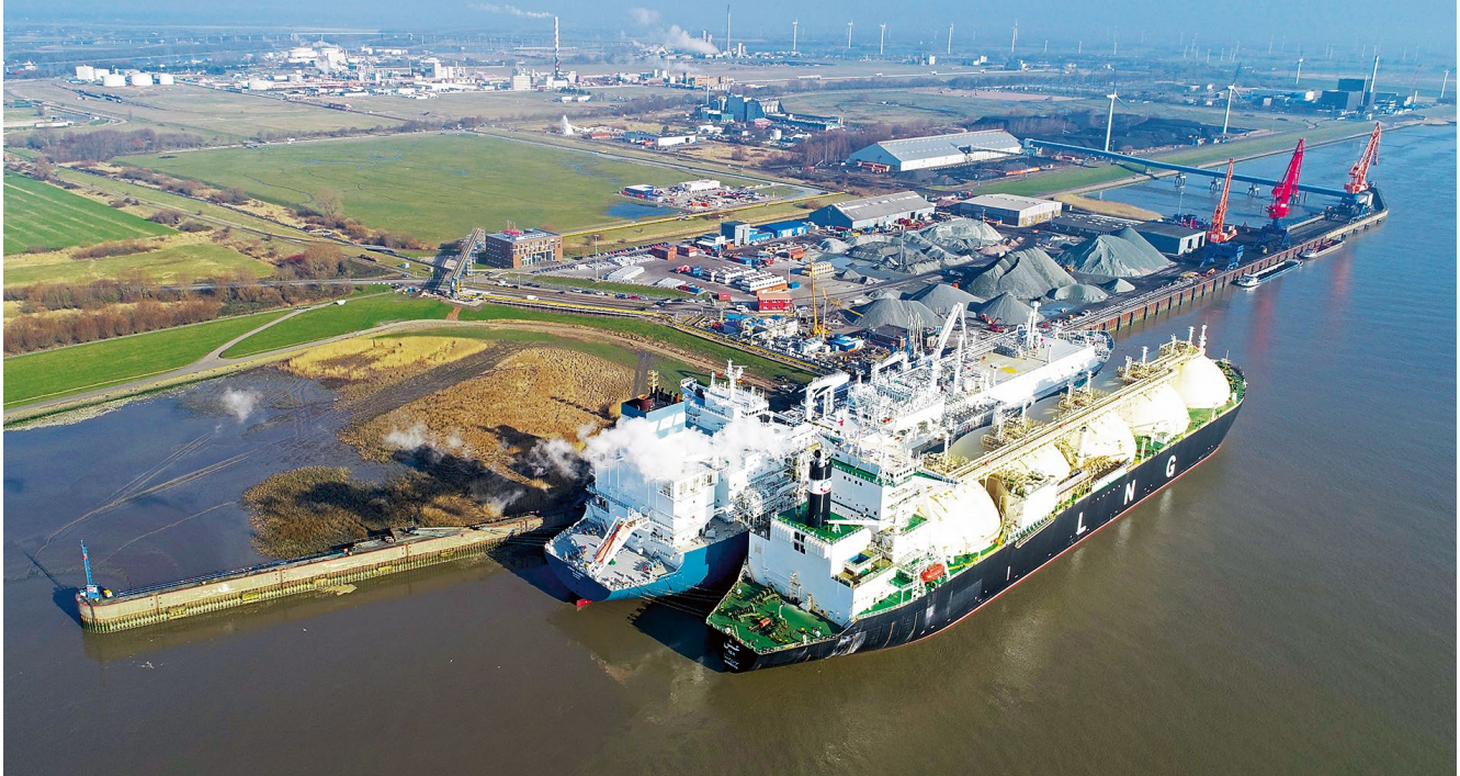
Der LNG-Tanker „ISH“ neben der Floating Storage and Regasification Unit (FSRU) „Hoegh Gannet“ im Brunsbütteler Elbehafen.
