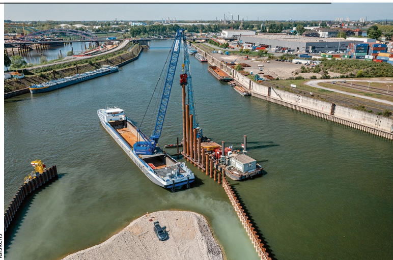
Auf diesem Luftbild sieht man das Einbringen der Rohre, die später mit Spundbohlen verbunden werden.
